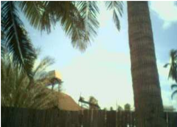
a - Chauffe-eau d'un Hôtel (L'Arche de Noé)
