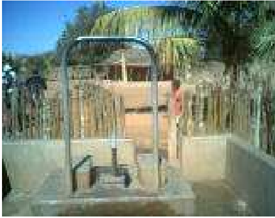
c - Forage muni d'une pompe pédale (vergné) à Ambohimpitiavana
