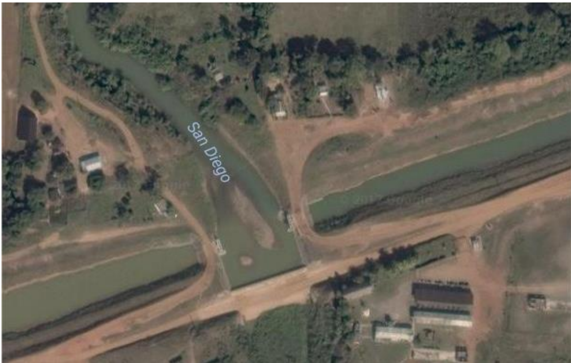
Figura A1.3 Derivadora Río San Diego, a la derecha tramo de canal magistral San Diego-Los Palacios y a la derecha tramo San Diego Herradura. Tomado de: Google Earth.
